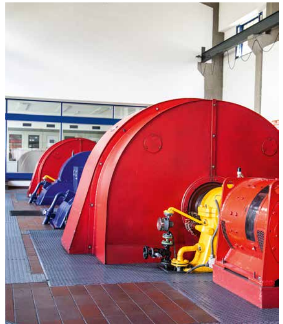
Zwei Turbinensätze erzeugen im Kraftwerk Volders Strom. Nach dem „Repowering“ steigt die Leistung von jeweils 3,34 MW auf 5 MW
