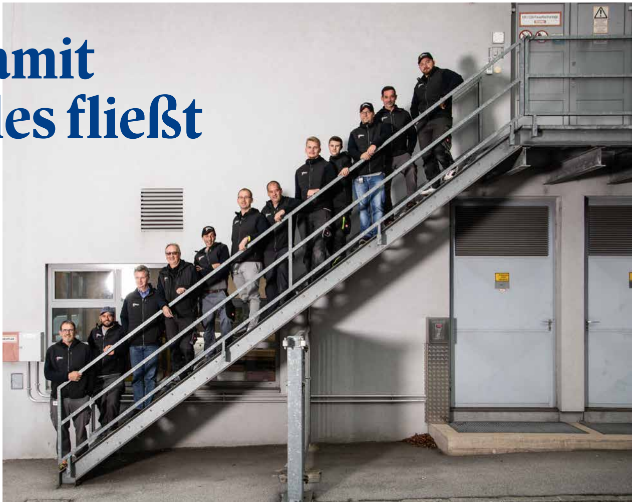
Das Team vom Fachbereich Strom der Hall AG sorgt dafür, dass der Strom verlässlich vom Kraftwerk bis nachhause kommt
