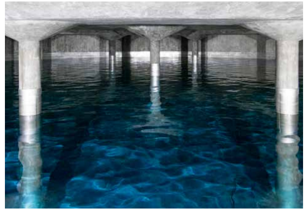
Das Trinkwasser in den Hochbehältern kennt keine Nachtruhe
