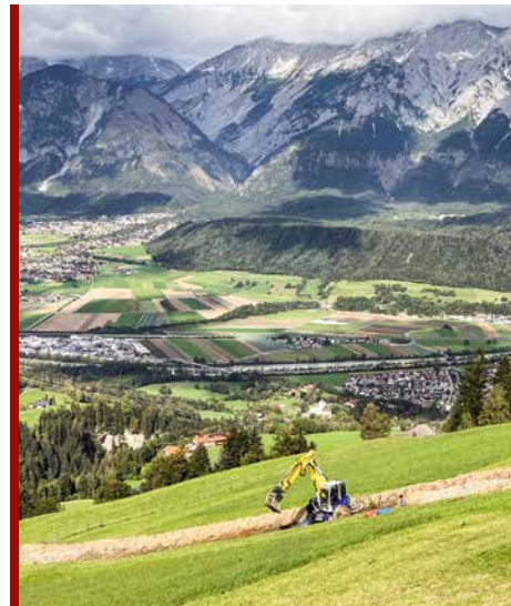
Am Volderberg errichtet die Hall AG eine neue Trafostation samt Zuleitung
