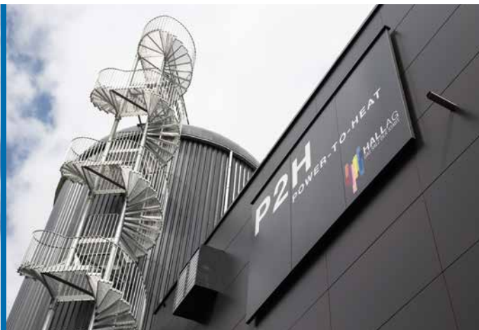
Seit 2023 im Netz: der Power-to-Heat-Turm
