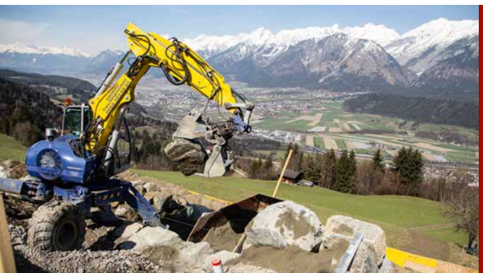
Baustelle mit Aussicht: Hier wächst die Natursteinmauer für die Trafostation Schweighof am Großvolderberg
