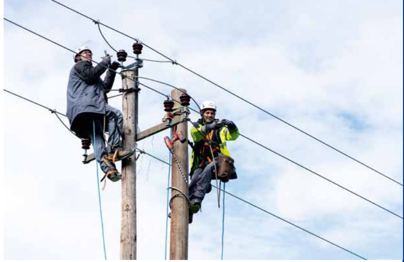
Im Außeneinsatz kümmern sich die Techniker des Bereichs Stromnetz darum, dass der Strom verlässlich fließt
