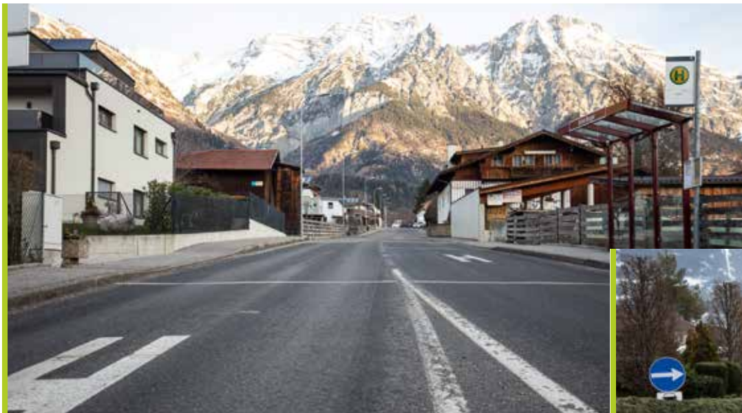
Die Bauarbeiten am nördlichen Teil der Salzbergstraße beginnen im April (o.), der Abschnitt südlich des Linger-Kreisverkehrs folgt im Juli (r.).
